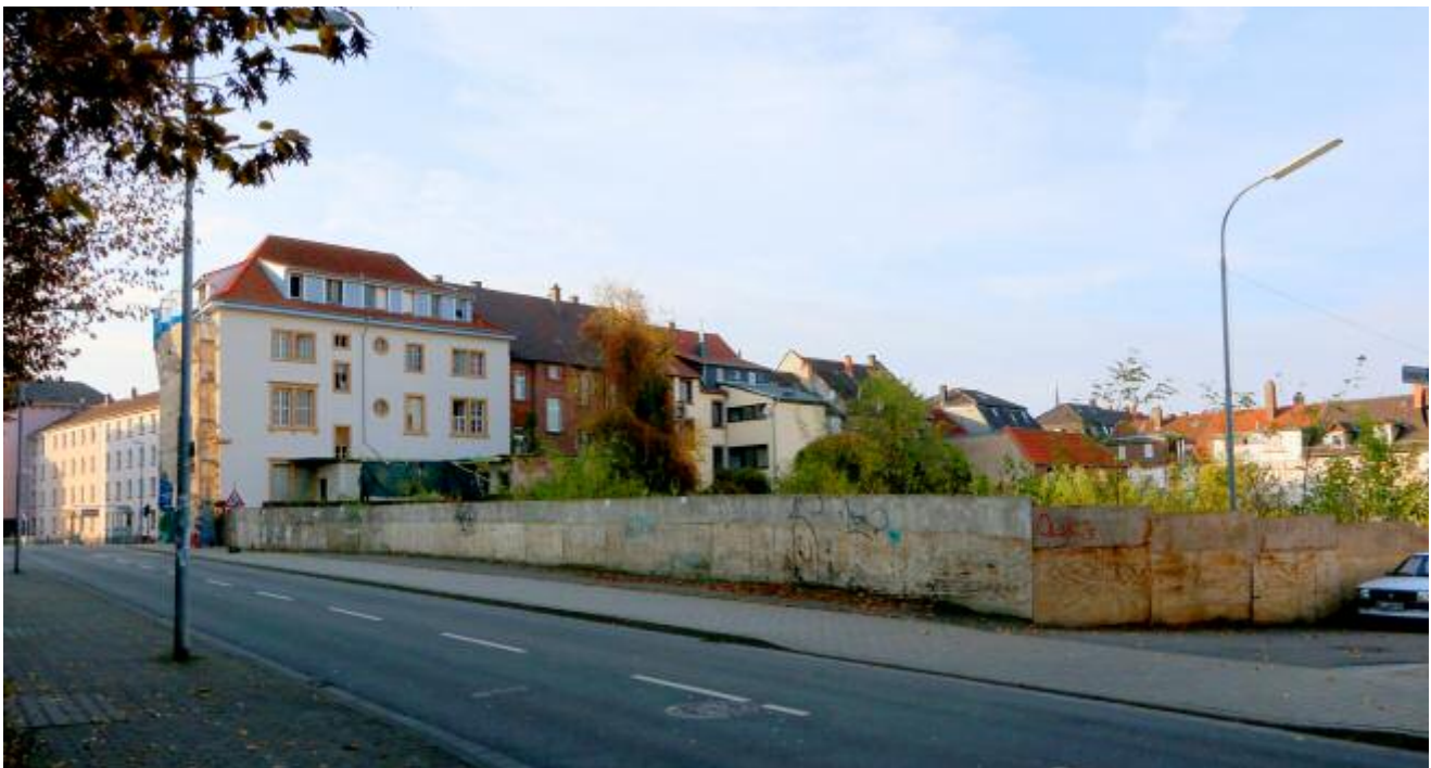
Große Baulücke an einer innerstädtischen Hauptverkehrsstraße, Kaiserslautern
