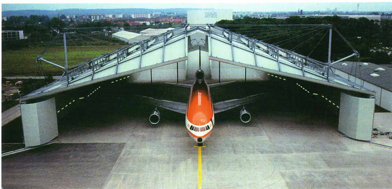
Abbildung 1 Lärmschutzhalle für Triebwerksprobeläufe am Flugplatz Düsseldorf
